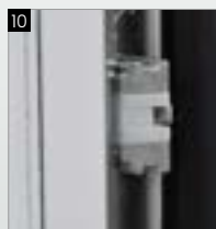
10 Zasuwnica GU rygłowanie dolne
